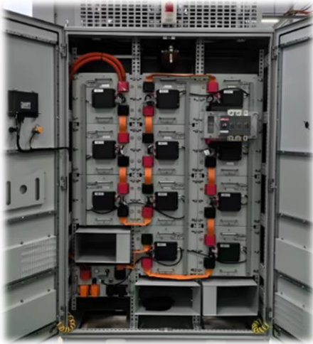
LICキャパシタ盤 (600V-820 \mu F 出力4MW-10min)
